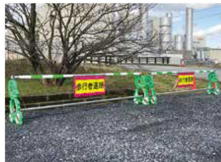
バリケード取付
